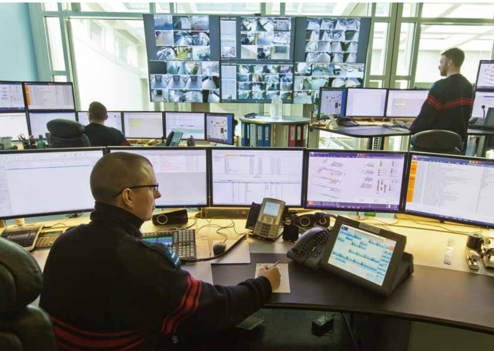
Die Überwachungszentrale von Securitrans am Hauptbahnhof Zürich ist sieben Tage die Woche rund um die Uhr besetzt.
